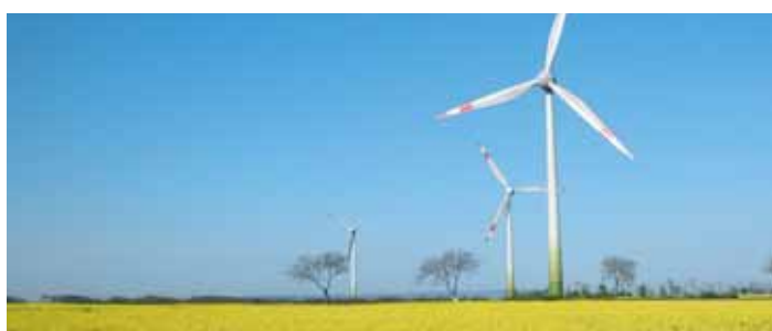
Větrný park Poysdorf-Wiifersdorf – Rakousko, 14 zařízení Vesta V90 – 28,0 MW
