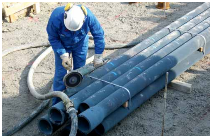
Na první pilotě se vyřízne injektážní štěrbiná
