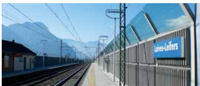
Protihluková ochrana Brennerachse – Itálie, 4,5 km železniční tratě
