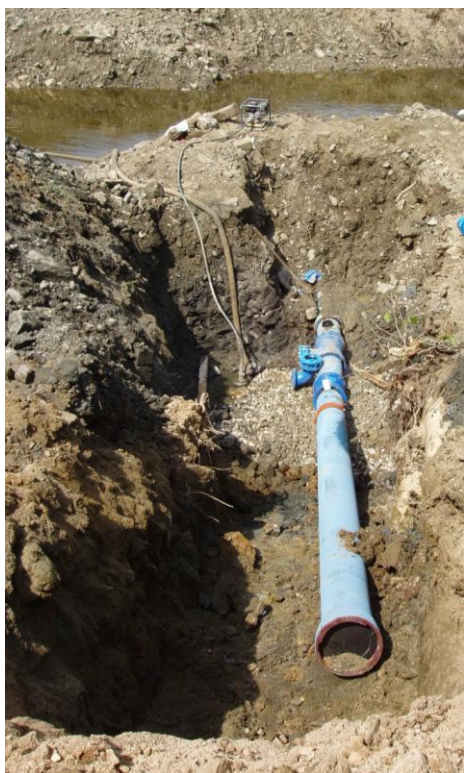
Obr. 3 Rameno vodovodní shybky
