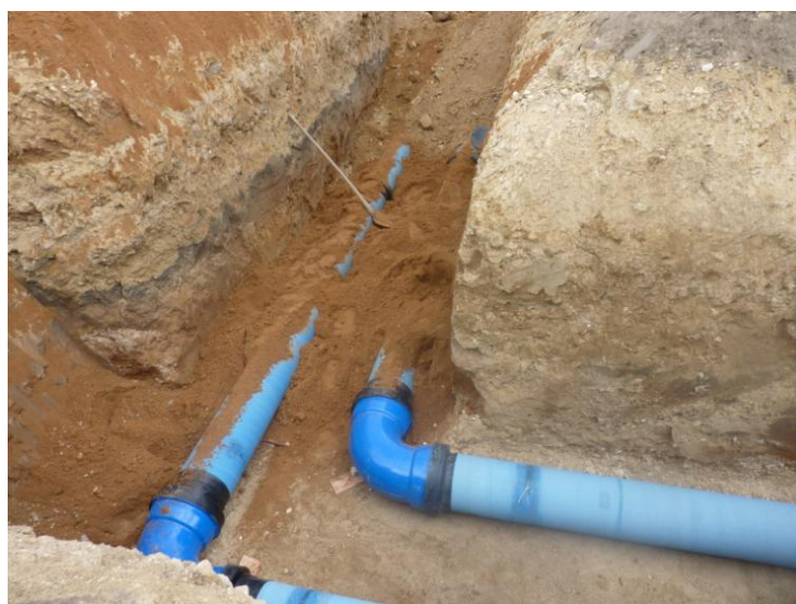
Obr. 6 Pokládka trub OCM
