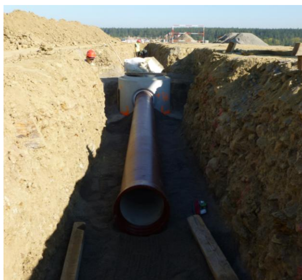
Obr. 5 Příklad uložení kanalizačního potrubí
