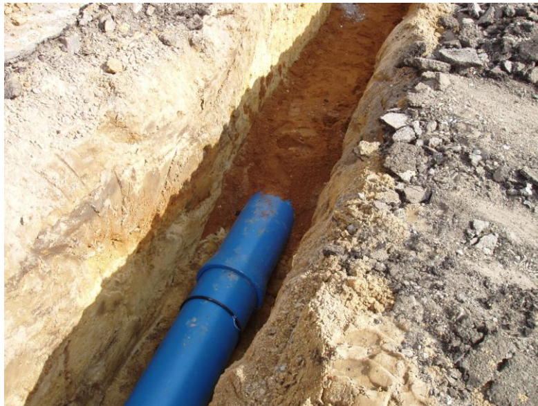
Obr. 1 Pokládka trub DN 400
