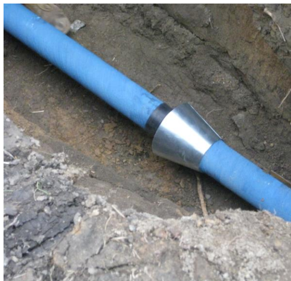
Obr. 3. Kompletní spoj připravený pro zatažení
