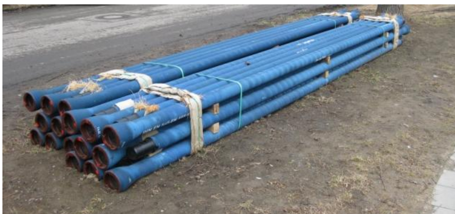
Obr. 1. Potrubí OCM před pokládkou
