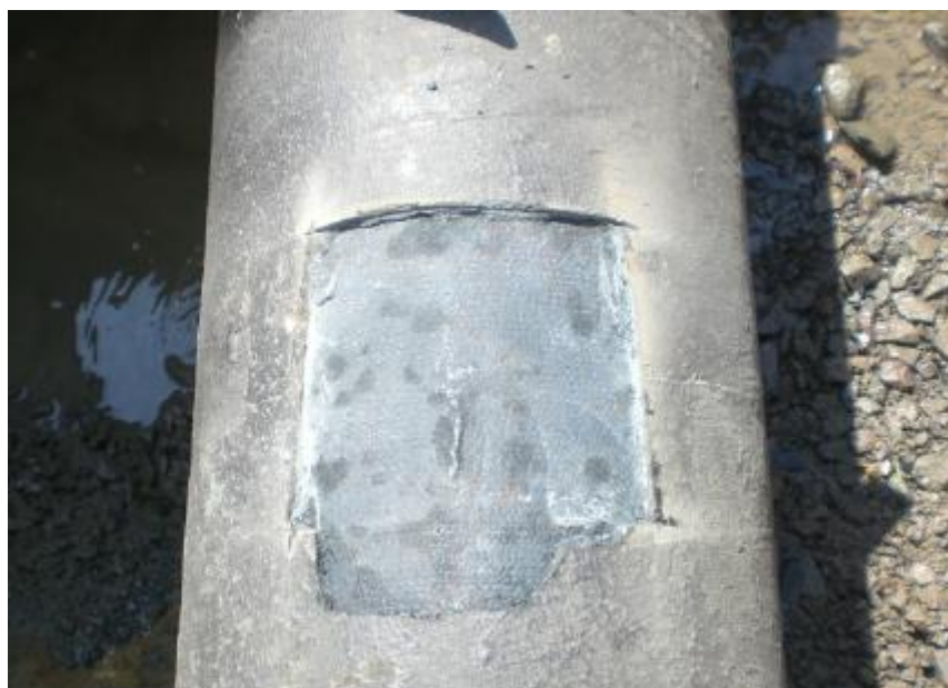
Obr. 2. Vyhloubené potrubí OCM/ZMU po 32 letech
